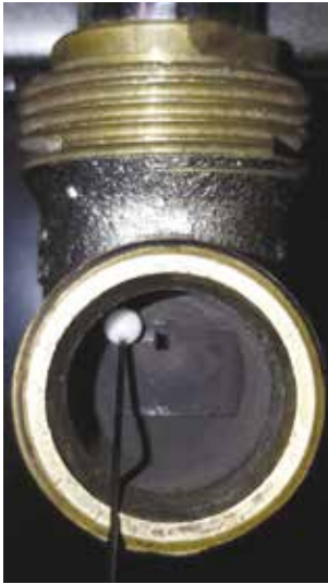
Patteriventtiilin ahtaat tiehyet.
