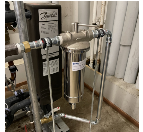
Sivuvirtasuodatin sakanpoistoa varten
