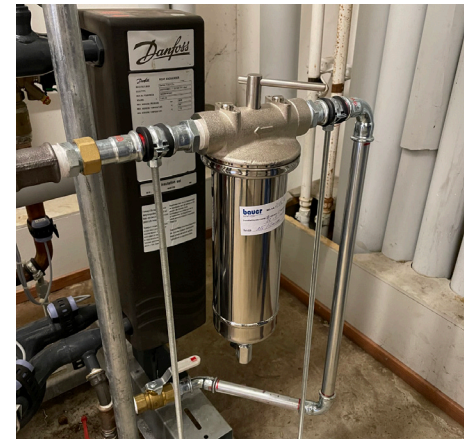
By-pass-filter för borttagning av avlagringar
